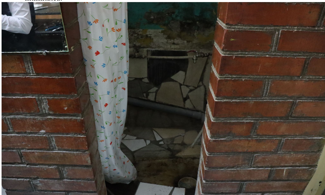
Foto_OAP_P13_celula 129_bloc sanitar_21/05/2021
