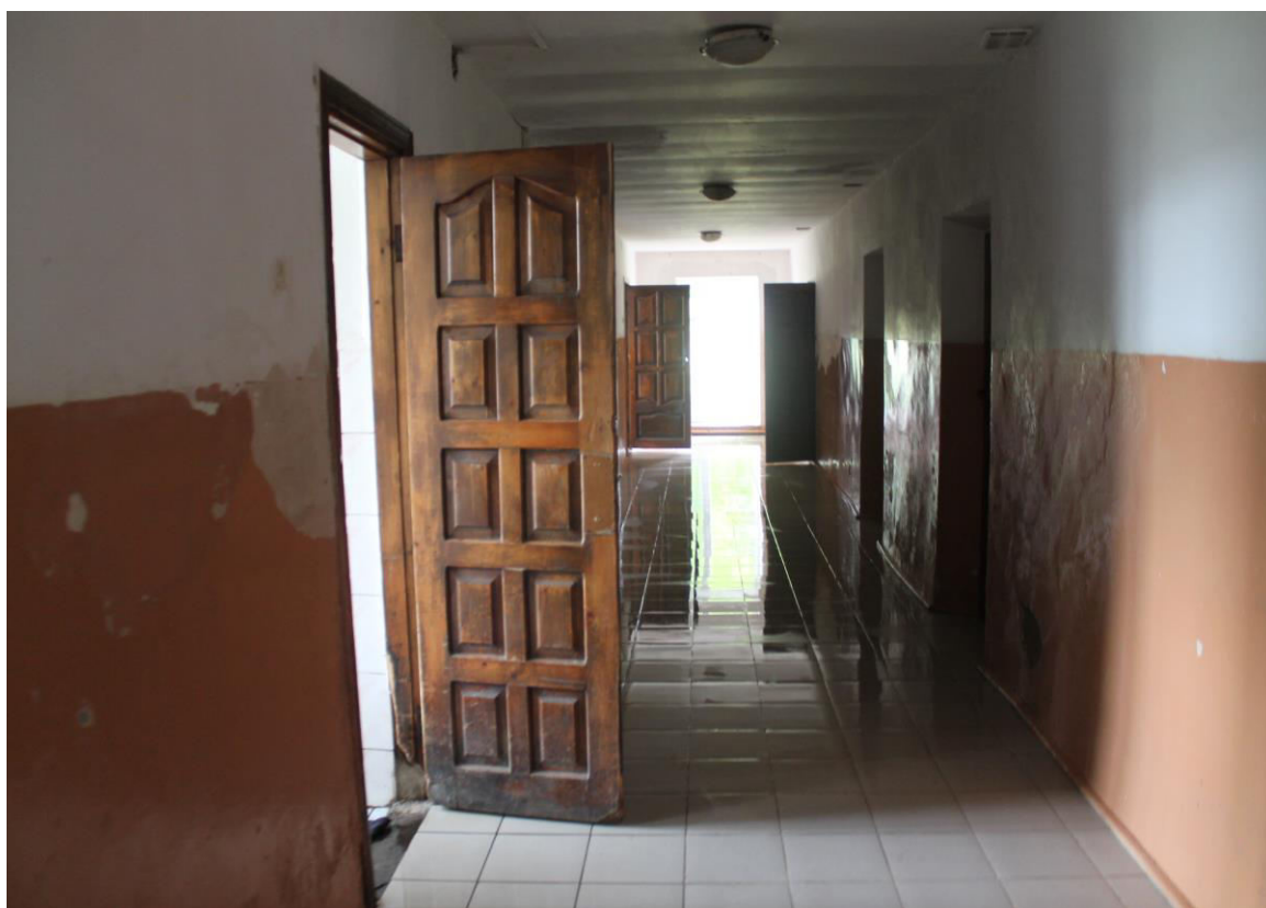
Foto din blocul nr.I și II (fără reparație)
