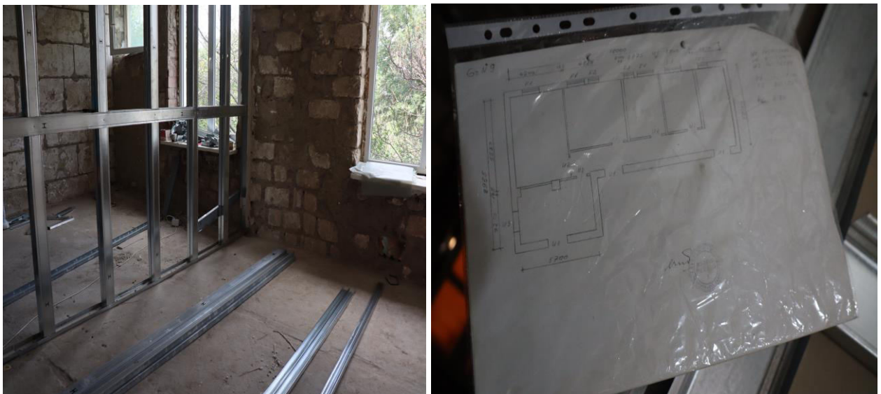
Foto_OAP_CPT Bădiceni_dormitoare etajul II_05.08.2021
