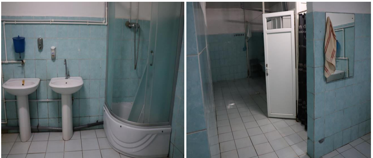
Foto_OAP_CPT Bădiceni_bloc sanitar_05.08.2021
